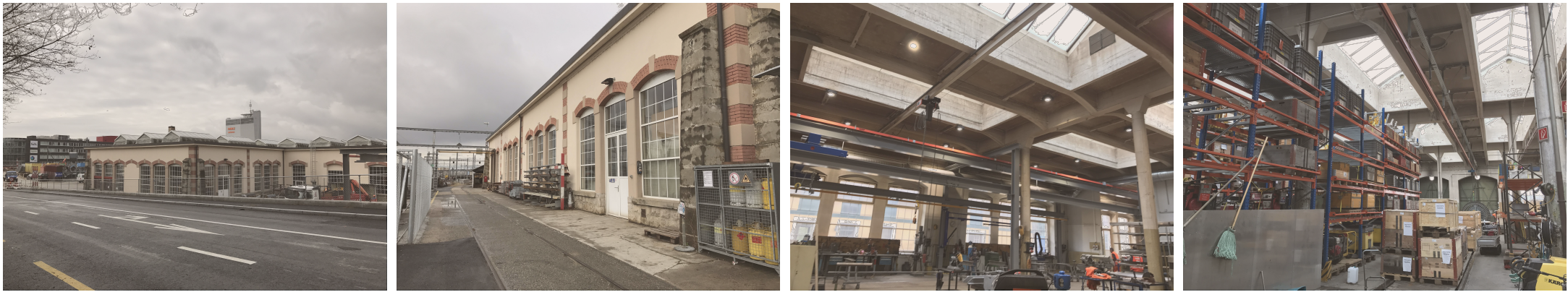
Photos de l'état existant
